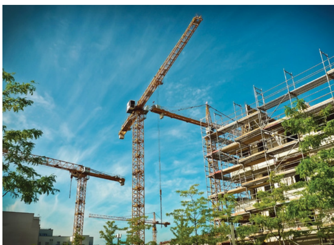
THI CÔNG XÂY DỰNG, XÂY LẮP CÁC CÔNG TRÌNH CÔNG NGHIỆP
